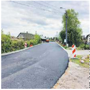
Trwa budowa ul. Orzeszkowej
