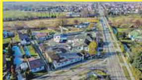
Nieruchomość przemysłowa w Międzyrzeczu Podlaskim z istniejącą hurtownią spożywczą i stacją gazu LPG, przy ulicy Warszawskiej, blisko wyłotu na drogę E 30 (krajowa A2), 665 750 197
