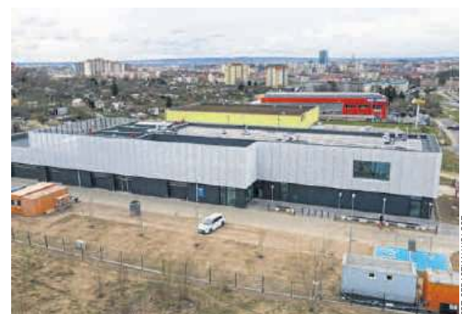
Wykonawca zadeklarował, że wybuduje obiekt w 15 miesięcy. Umowę podpisano 13 marca 2020 roku
