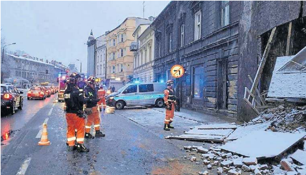
Służby zabezpieczyły teren i sprawdziły stan budynku. Na szczęście nikt nie ucierpiał
