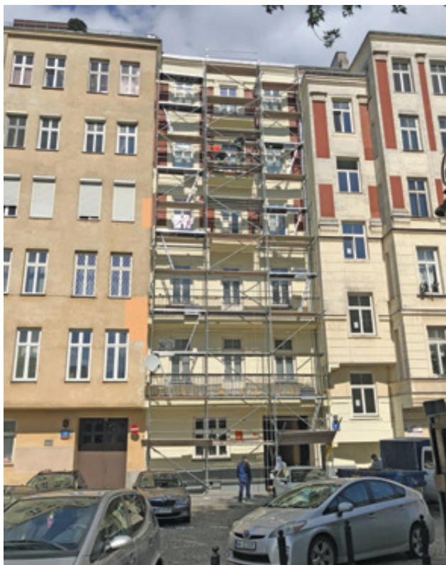
Fot. Renowacja balkonów pięciopiętrowej kamienicy przy ulicy Smolnej w Warszawie
