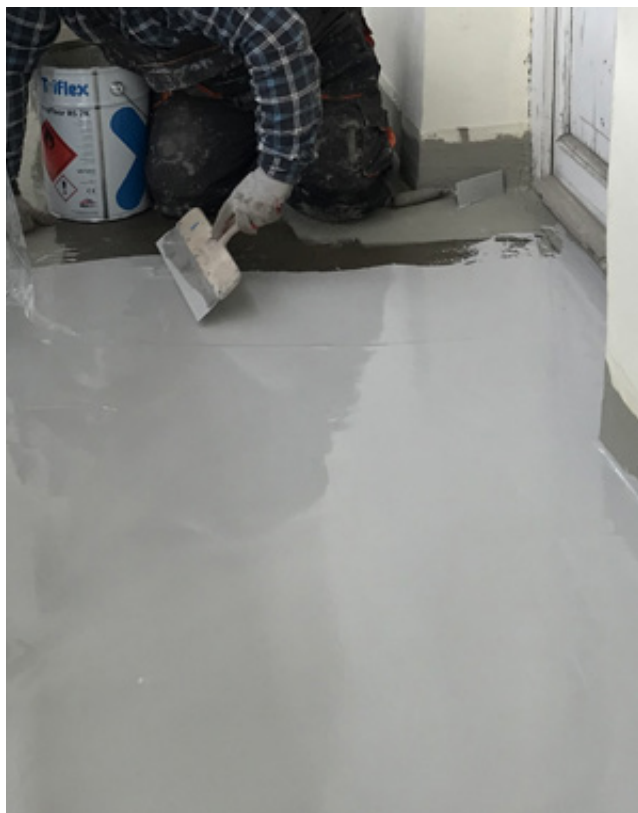
Fot. Aplikacja warstwy nośnej systemu hydroizolacyjnego /Fot. Triflex/
