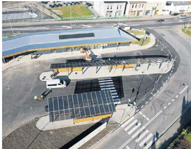
Zakończyła się budowa centrum przesiadkowego w Trzebini – powstało tuż przy odnowionej stacji kolejowej
