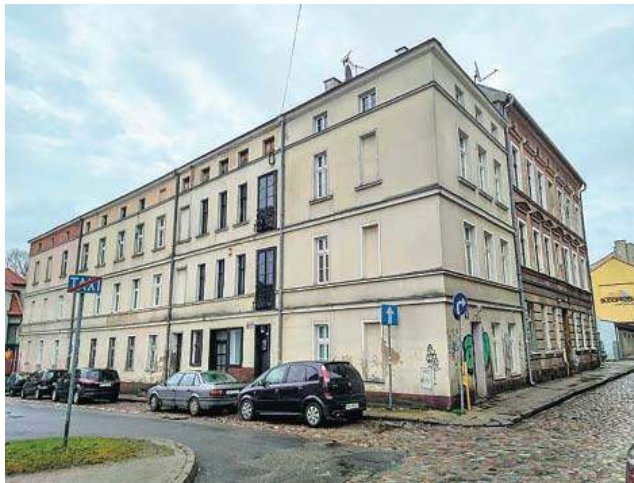
Kamienice przy ulicy Orkana w Olsztynie przekazane właścicielce
