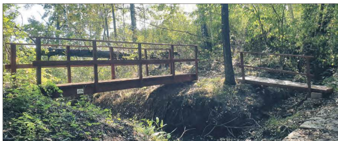
Nowe mostki na Dębowieckim Potoku
