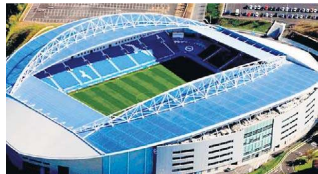
Stadion Brighton & Hove Albion, na którym przegrali piłkarze Arsenalu
