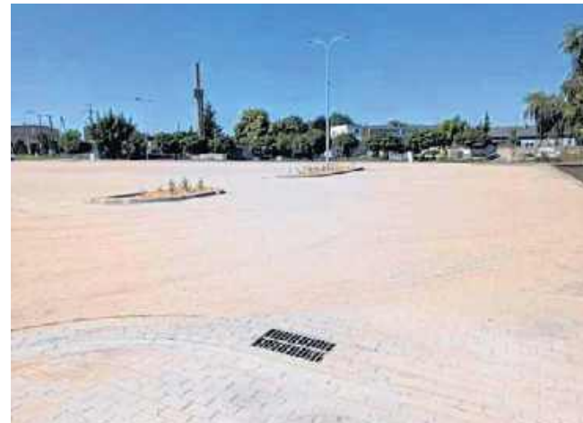
Przy stadionie miejskim w Gołańczy powstał nowy, komfortowy parking.
