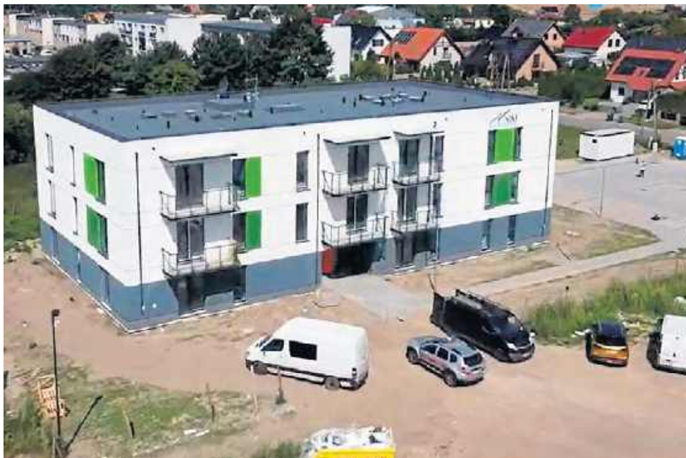
Prace w Mieścisku na ostatniej prostej.
