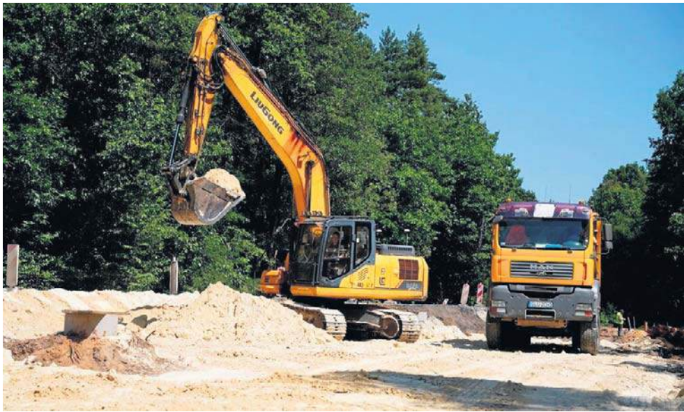
Budowa ronda na skrzyżowaniu ul. Hrubieszowskiej i ul. Szerokotorowej
