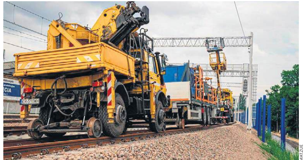
Prace sieciowe i roboty związane z balastowaniem torów oraz rozjazdów w Sosnowcu
