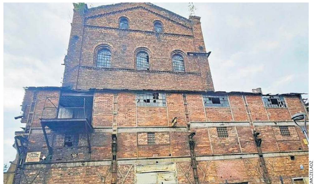
Trwa modernizacja szybu basztowego na terenie byłej KWK Saturn w Czeladzi
