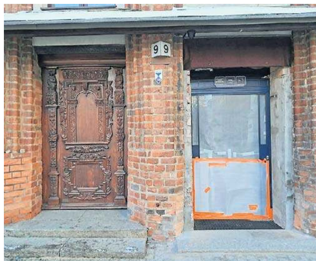
Te drzwi, które absolutnie nie pasują do zabytkowego budynku, to rozwiązanie tymczasowe
