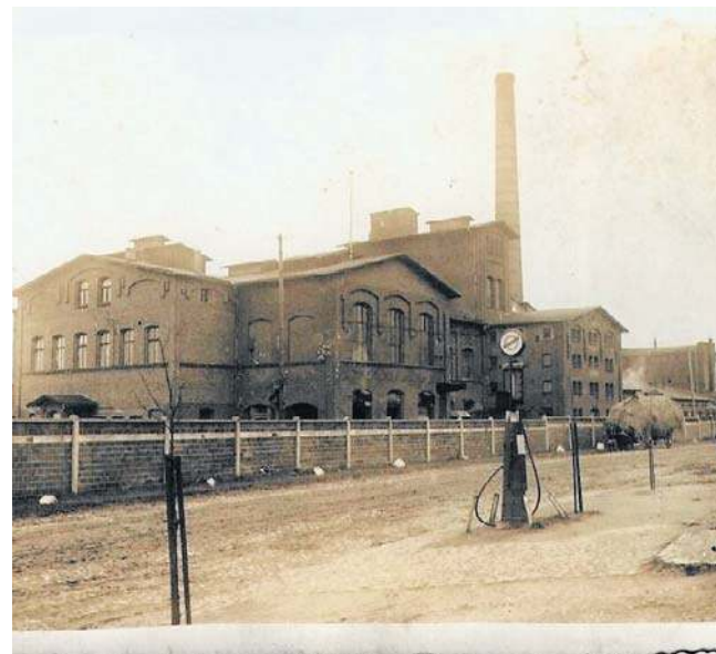
Cukrownia w Unisławiu przerobiła 71.600 ton buraków
