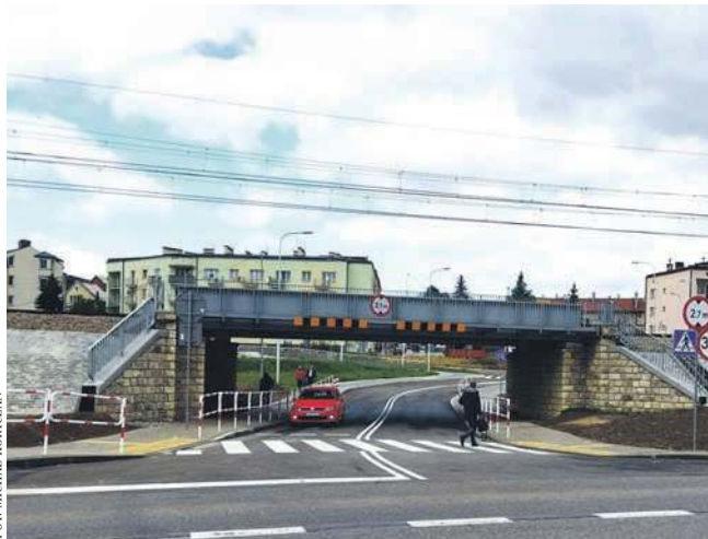
Wiadukt nad ul. 29 Listopada w Chrzanowie
