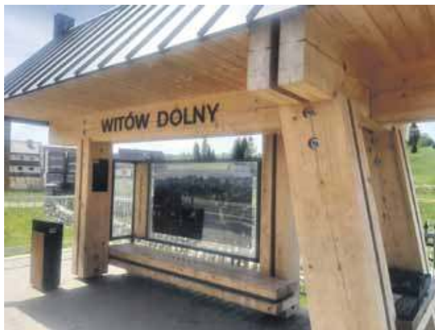
Zadaszony, z panoramą Tatr Zachodnich, ławą dla pasażerów, miejscem na rowery i przestrzenną mapą dla niewidomych przystanek w Witowie Dolnym
