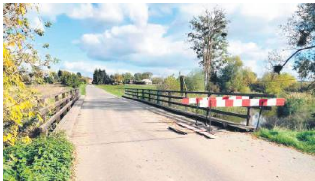
Trwa naprawa mostu w Brodnicy. Do Hrubieszowa trzeba jechać objazdem przez Wolicę.
