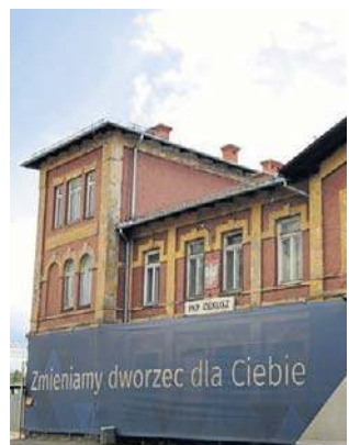
Dworzec w Olkuszu przejdzie kompleksowy remont
