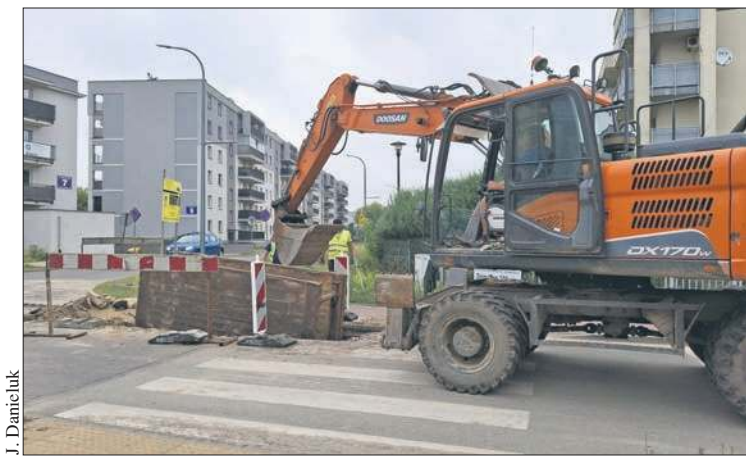
Początek prac na ul. Maneżowej
