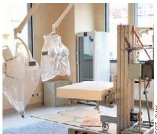
Prace remontowe dobiegają końca.
