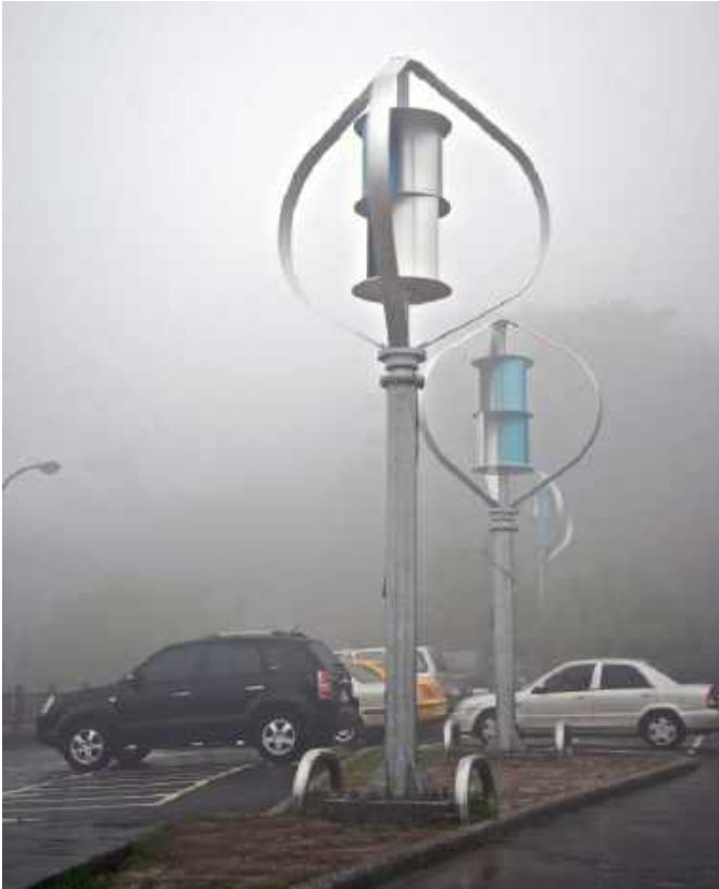
Fotografia 4. Hybrydowa turbina Savonius-Darrieus używana na Tajwanie
