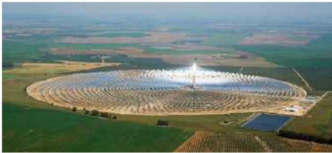
Fotografia 2. Elektrownia słoneczna Gemasolar skupia światło słoneczne na umiejscowionym na szczycie wieży zbiorniku ze stopioną solą, który jest termalnym magazynem energii, wytwarzającym parę wodną pod ciśnieniem dla turbin napędzających generatory
