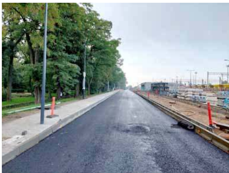
Kształtów nabiera również ścieżka rowerowa, a nowy chodnik jest na ukończeniu.
