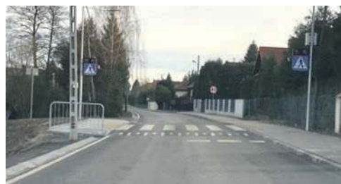
Wyremontowana ul. Miękińska w Krzeszowicach
