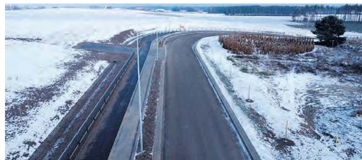
Inwestycja została zakończona miesiąc przed planowanym terminem.
