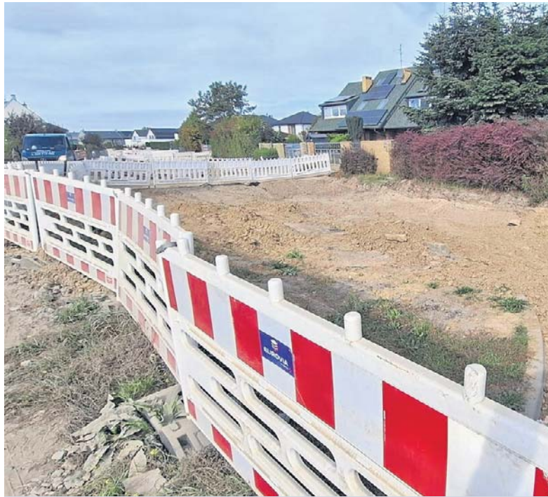
Mieszkańcy mają dość przedłużającego się remontu drogi. Pytają o termin zakończenia
