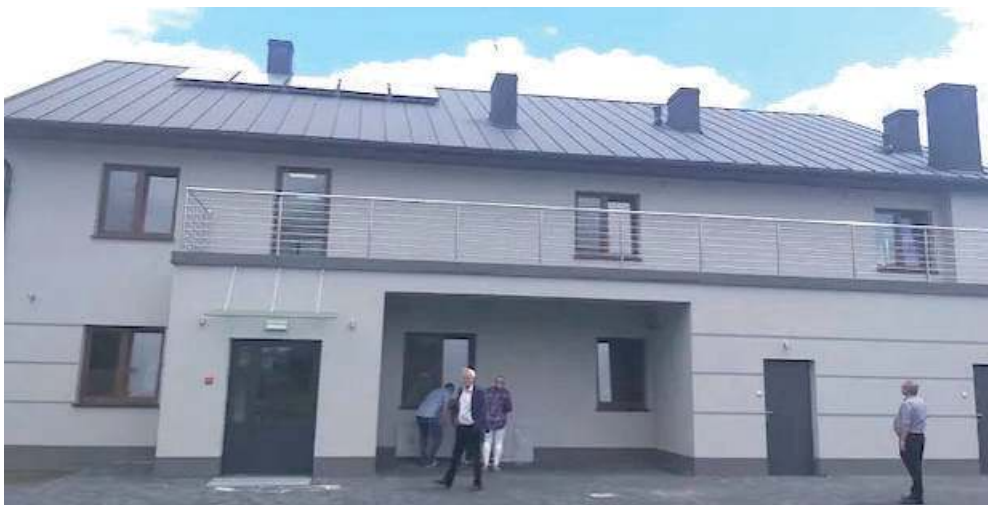
W ramach inwestycji w lipcu 2020 zakończyła się przebudowa budynku na stadionie miejskim
