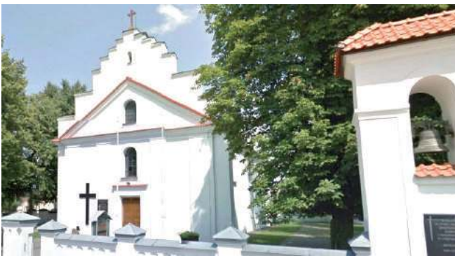
Remont i przebudowa kościoła zostaną dofinansowane kwotą ponad 680 tys. zł. Koszt całkowity wyniesie blisko 985 tys. zł. Projekt w trakcie oceny wniosków otrzymał 96/100 pkt.
