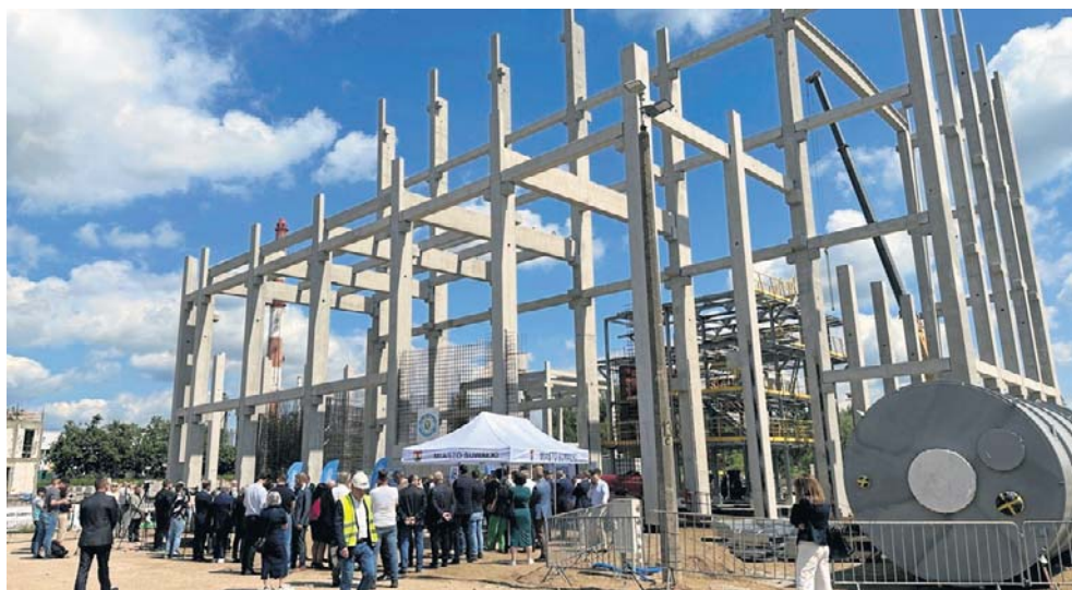
Instalacja Termicznego Przekształcania Wstępnie Przetworzonych Odpadów Komunalnych powstaje przy ulicy Przemysłowej w Suwałkach. To jedna z najważniejszych inwestycji w mieście w zakresie gospodarki odpadami i energetyki
