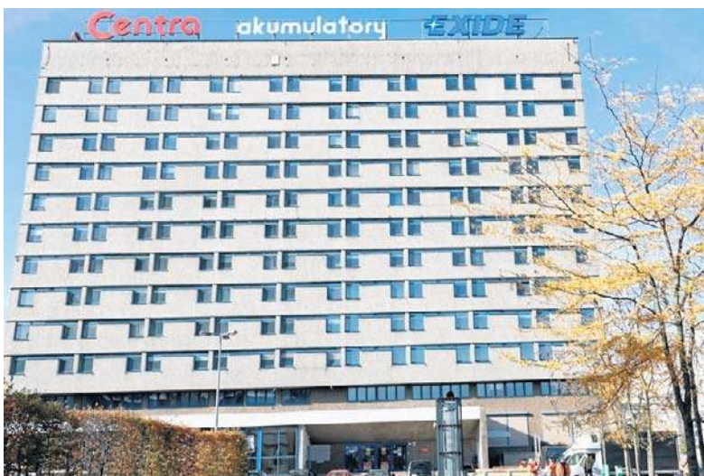
Tak obecnie wygląda Dom Studencki Jowita. Akademik w 2023 roku został zamknięty z powodu złego stanu technicznego
