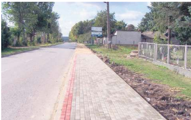
W Turobinie wybudowano chodnik na odcinku 648 m.
