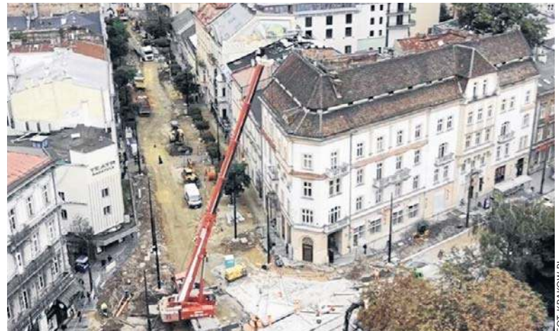
Przy Teatrze Bagatela trwa teraz montaż kluczowych elementów betonowych remontowanego skrzyżowania
