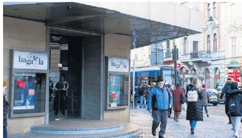
Teatr Bagatela czeka gruntowny remont i przebudowa
