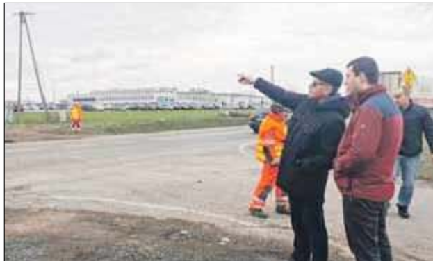
Ruszyły prace przy budowie ulicy roboczo zwanej „Przemysłową”. Ma zagwarantować skomunikowanie terenów inwestycyjnych miasta z k19
