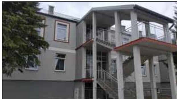
Przy ul. Kościuszki w Janowie Podlaskim, w budynku po dawnym przedszkolu powstało 20 lokali socjalnych
