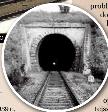
Stacja kolejowa w Mostach i wjazd do tunelu Jabłonkowskiego
