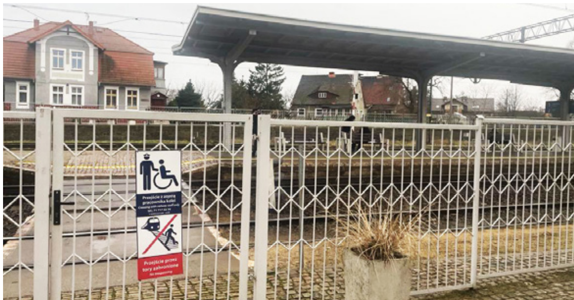
To właśnie to ogrodzenie i bramka zdenerwowały mieszkańców.
