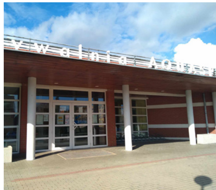
Termomodernizacja basenu to jedno z głównych zadań na nowy rok
