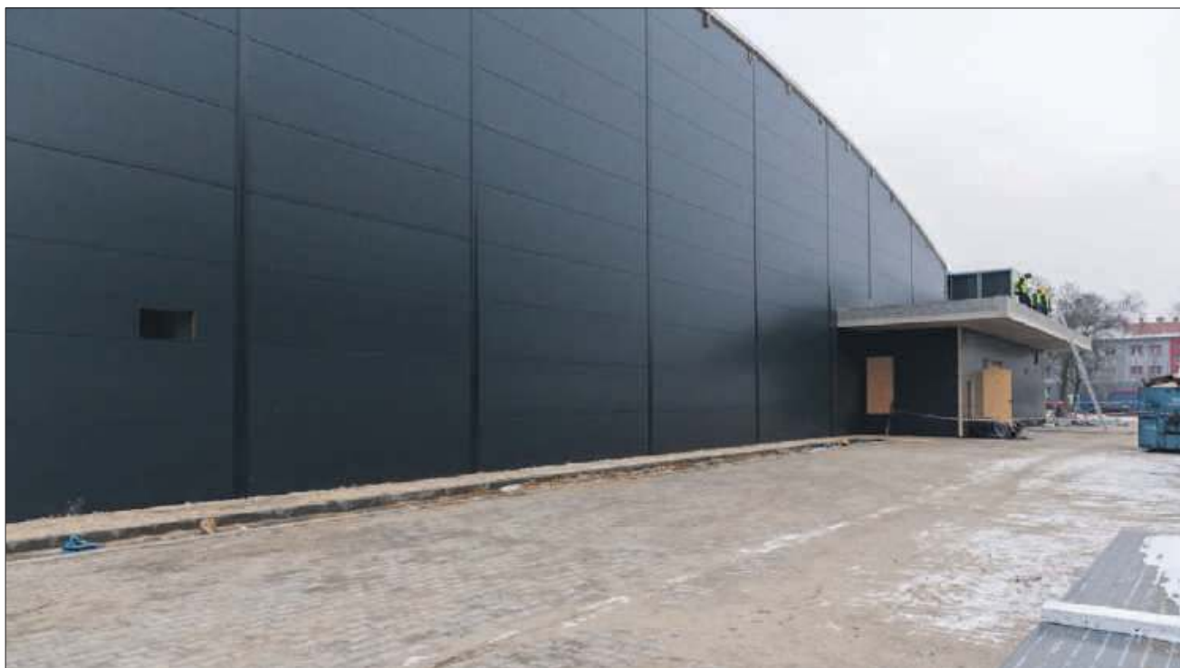
W zeszłym tygodniu na balkonie od południa montowano centrale wentylacyjne
