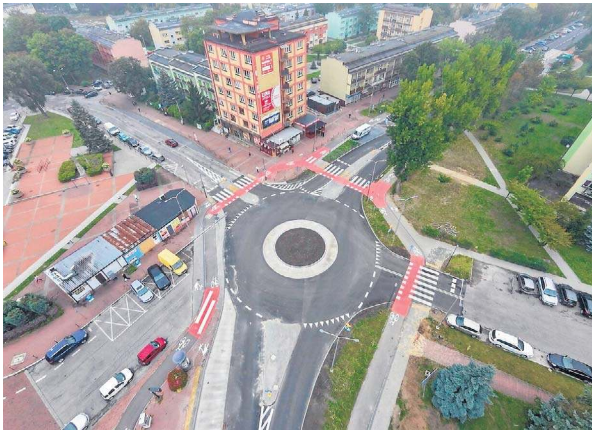
Ostatnio zakończyła się przebudowa ulic Wybickiego i Wiśniowej. Powstało tam m.in. nowe rondo
