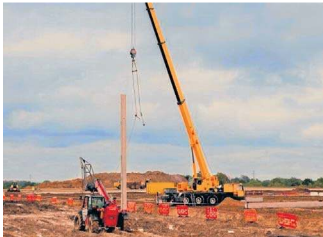
Rozpoczęto budowę parku logistycznego Quantum Gliwice. Otwarcie kompleksu zaplanowano na 2027 rok
