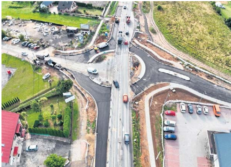
Modernizacja drogi krajowej nr 94 od Zedermana do Jerzmanowic
