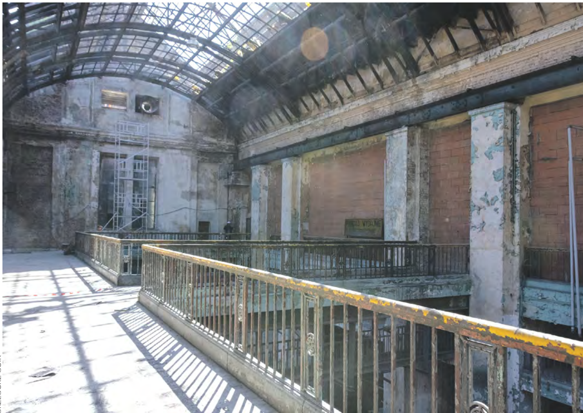
Stare wnętrza elektrociepłowni zyskują nowe funkcje użytkowe
