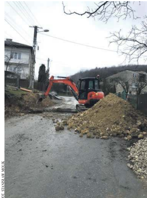
Prace przy budowie kanalizacji w Siedlcu wkrótce powinny się skończyć
