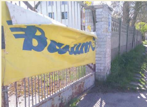
Skorodowana brama zamknięta na łańcuch, baner w marnym stanie i rozchylony chodnik z Polski Ludowej - bialski obraz osiągnięć przemysłowych?
