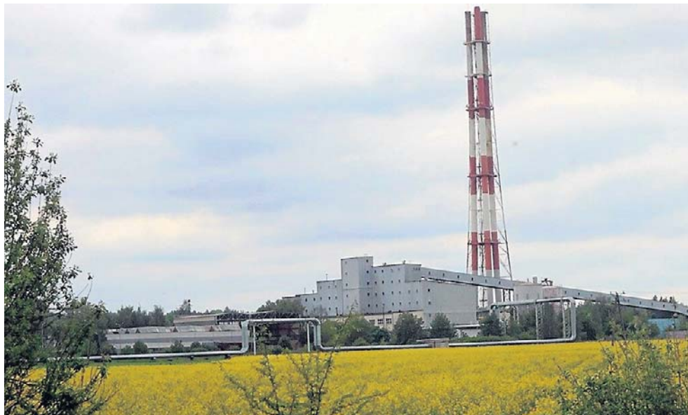
Centralna Ciepłownia ma kotły węglowe, jest mocno wyeksploatowana
