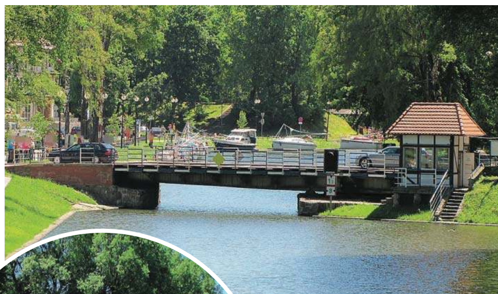
Tak wyglądał most przed remontem
