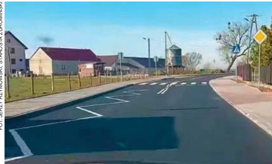
Przebudowana droga w miejscowości Stawiszyn-Łaziska.
