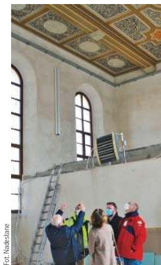
Fot. Nadejane Komisja podczas odbioru odrestaurowanych zdobień stropu
