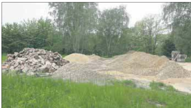
Teren parku wciąż jest placem budowy
