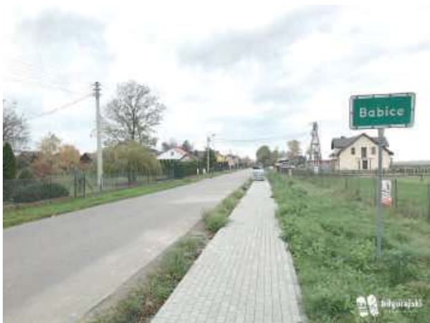
Prace są planowane na 12 odcinkach o łącznej długości ponad 8 kilometrów
