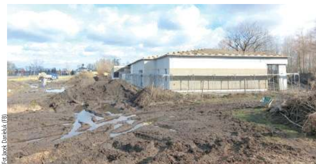
Trochę zimy, trochę wiosny, ale to nie przeszkadza w budowie rozległego budynku przedszkola i żłobka
