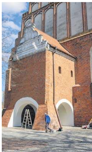
Trwa spory remont bydgoskiej katedry
