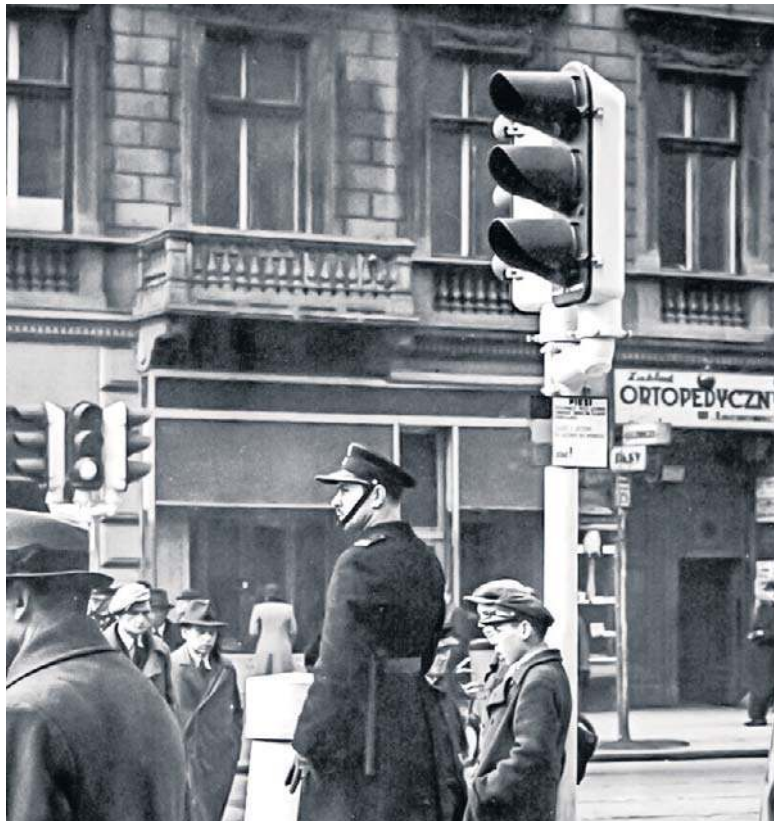
W Warszawie sygnalizacja pojawiła się w latach 20. Na zdjęciu z 1932 sygnalizacja na skrzyżowaniu Marszałkowskiej i Alei Jerozolimskich
