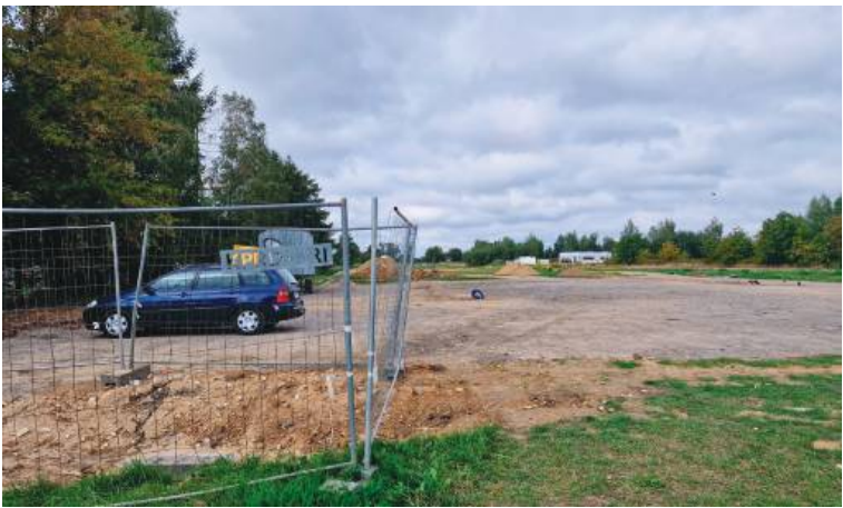
Na razie na budowie ul. Chryzantemowej jeszcze niewiele się dzieje
