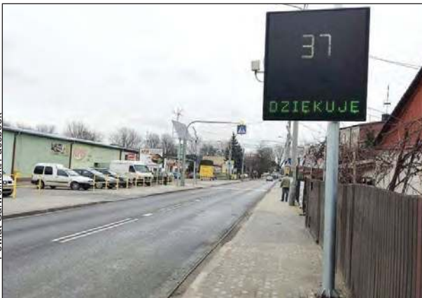
W ramach dofinansowania zamontowano dodatkowe oświetlenie i znak aktywny oraz System Dyscyplinowania Kierowców - tzw. radar
