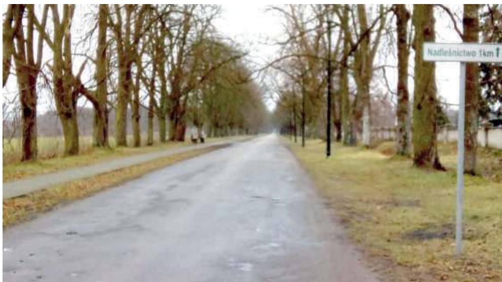
Stan drogi jest zły, jest wyboista i nierówna
