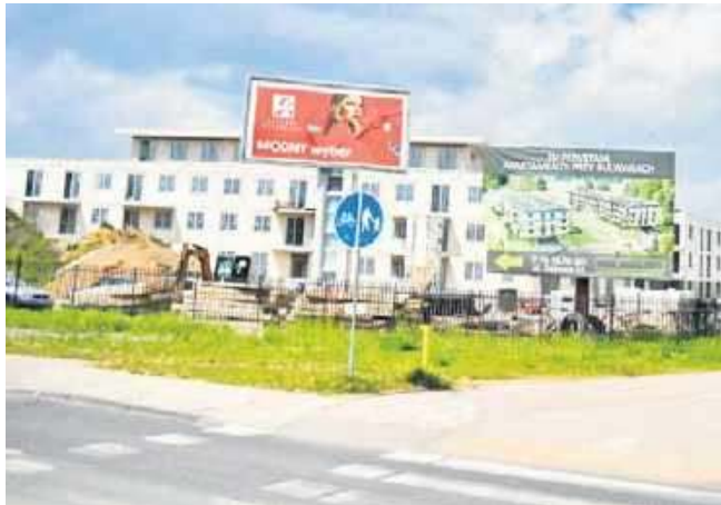
Na radomskich Borkach sprawnie posuwa się budowa miniosiedla „Apartamenty przy Bulwarach”.
