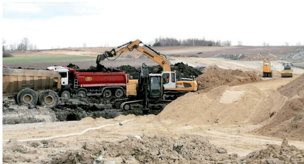
Budowa prowadzona jest po nowym śladzie. Na terenie gminy Chodel powstanie ma w sumie kilometr nowej drogi wojewódzkiej
